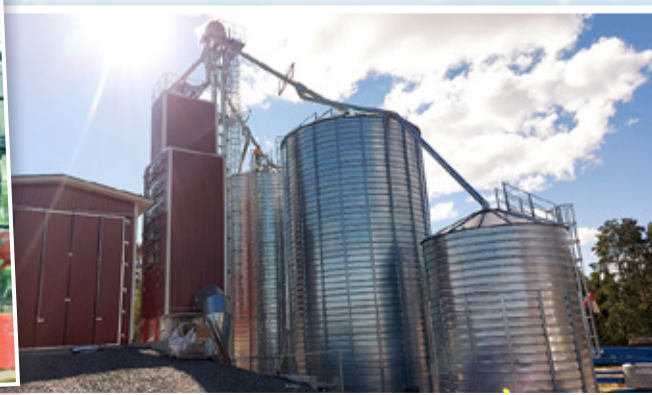
Kuva: Sähköasennus Sippola
