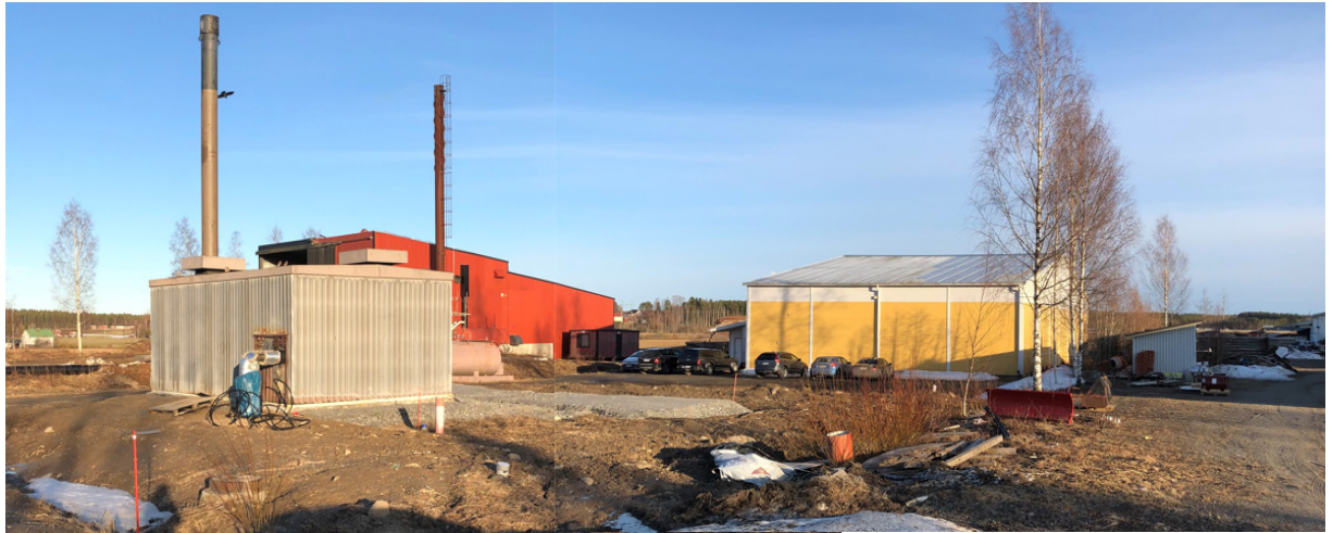
Kuva 4. Kaukolämpölaitoksen alue nykytilanteessa, tennishalli oikealla (Ramboll 04/2021).
