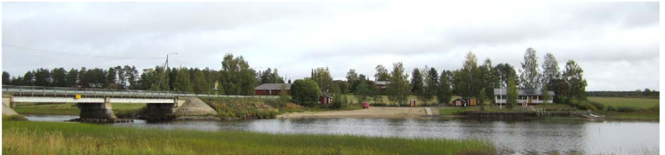
Kuva 18. Salmen silta, uimaranta ja venesatama.
