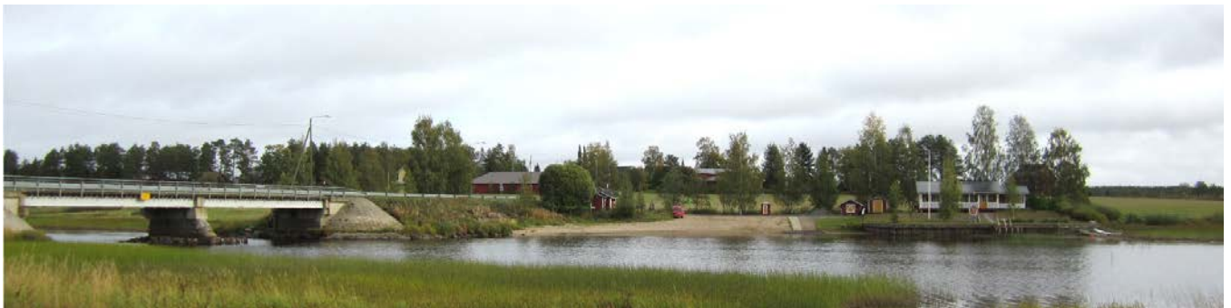
Kuva 16. Salmen silta, uimaranta ja venesatama.
