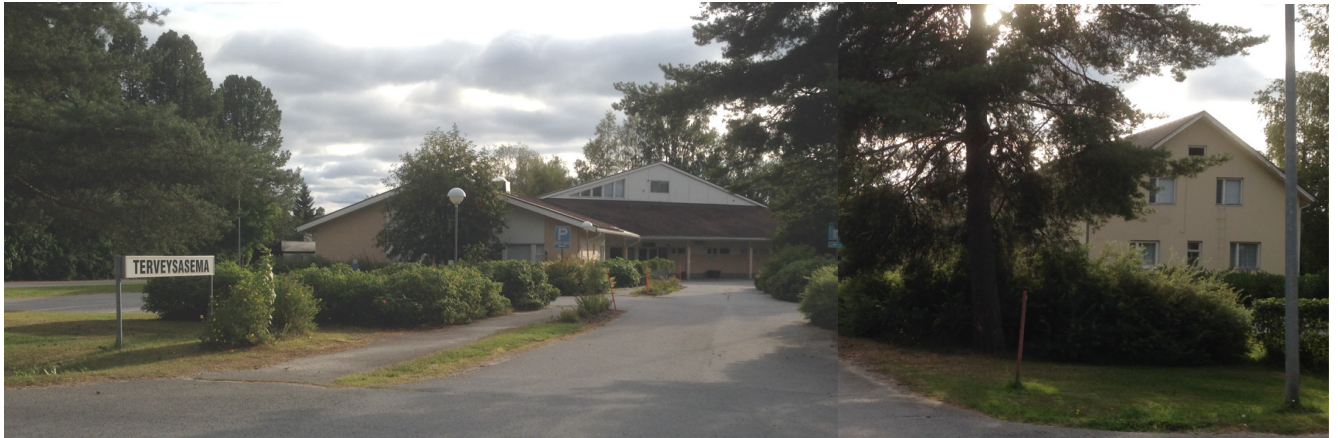
Kuva 5. Kuva alueelta Keskustieltä terveyskeskuksen liittymän kohdasta vuonna 2019, jonka jälkeen alueelta on purettu oikealla näkyvä rakennus (Ramboll 07/2019).
