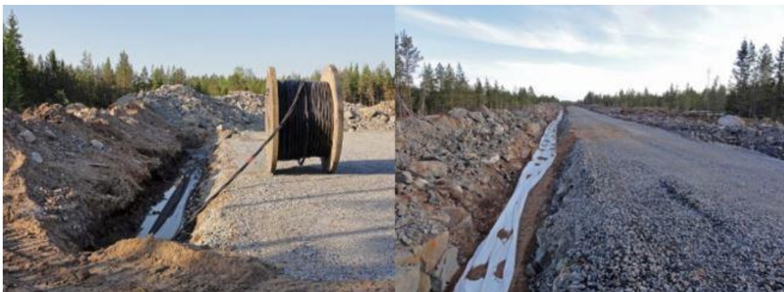
Kuva 18. Maakaapelit upotetaan huoltoteiden yhteyteen (Ville Suorsa, FCG).
