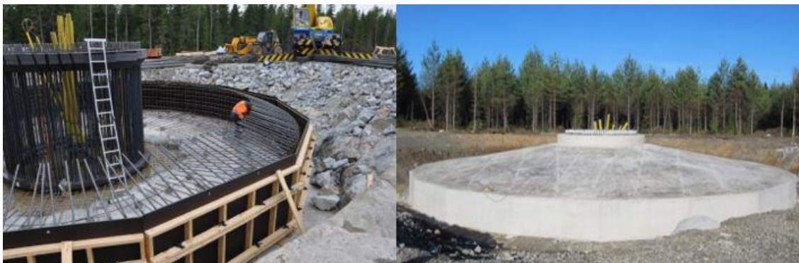
Kuva 19. Tuulivoimalan perustusten rakentamista (Leila Väyrynen, FCG).
