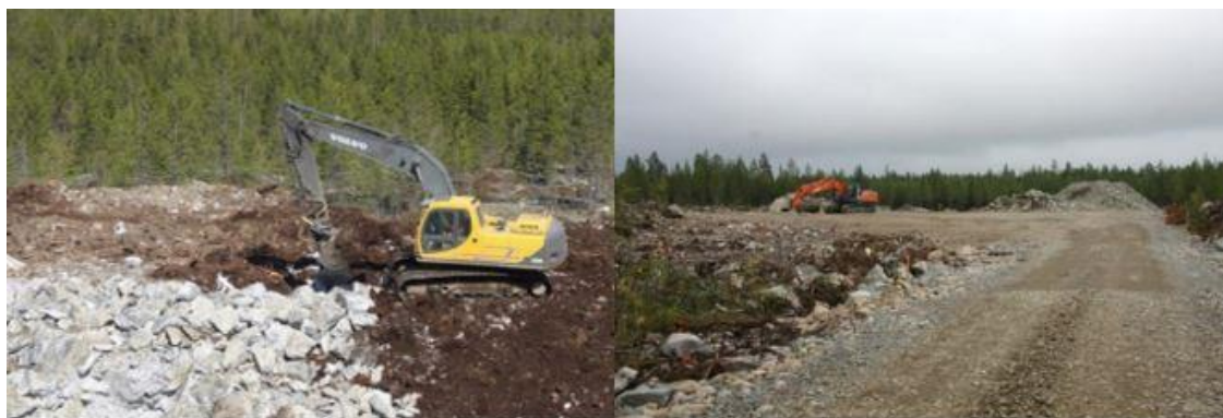
Kuva 17. Tuulivoimapuiston rakentaminen alkaa huoltoteiden ja pystytysalueiden rakentamisella (Ville Suorsa, FCG).
