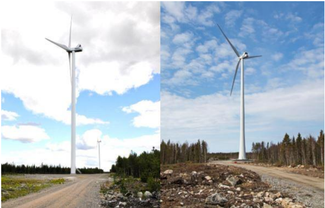
Kuva 12. Vasemmalla on esimerkki teräslieriötornista ja oikealla hybriditornista (Leila Väyrynen ja Ville Suorsa, FCG).
