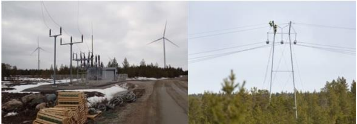
Kuva 22. Sähköaseman ja voimajohdon rakentamista (Ville Suorsa, FCG).
