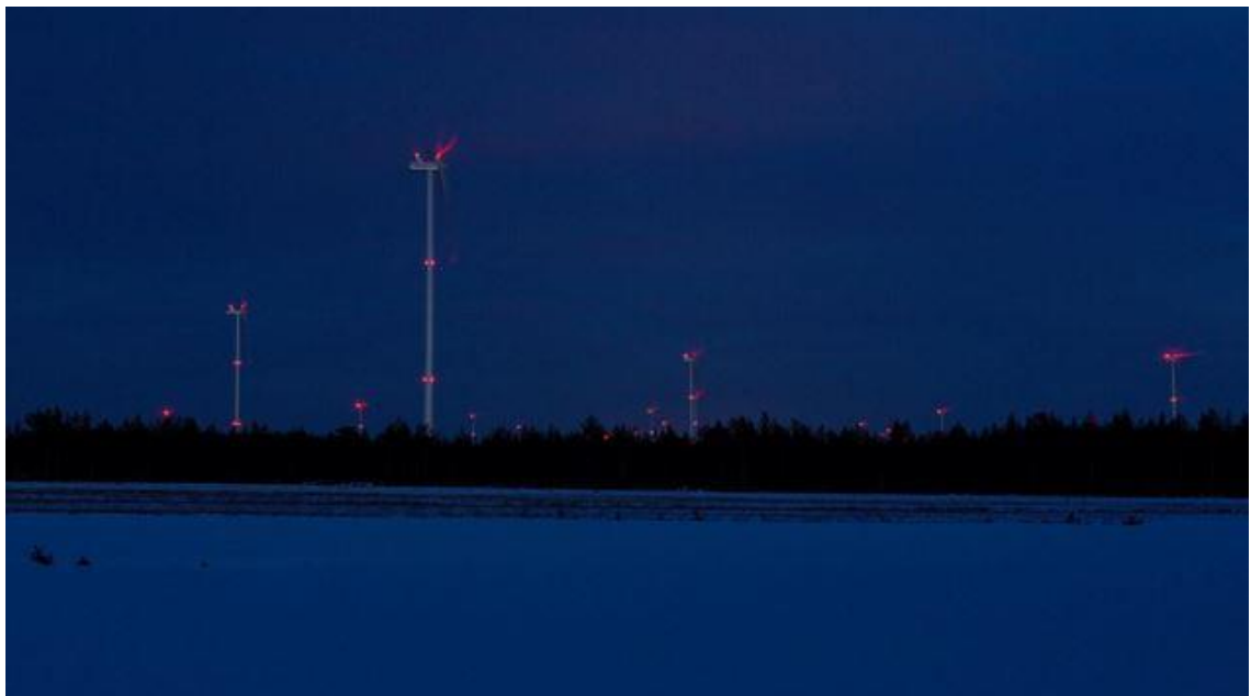
Kuva 13. Kiinteät punaiset lentoestevalot (Ville Suorsa, FCG).
