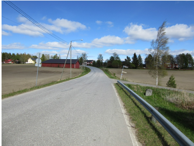
Salmen mäen eteläosan rakennuskantaa koilliseen. Yli-Salmen kantatalon paikka tien suoran päässä tien oikealla puolella.
