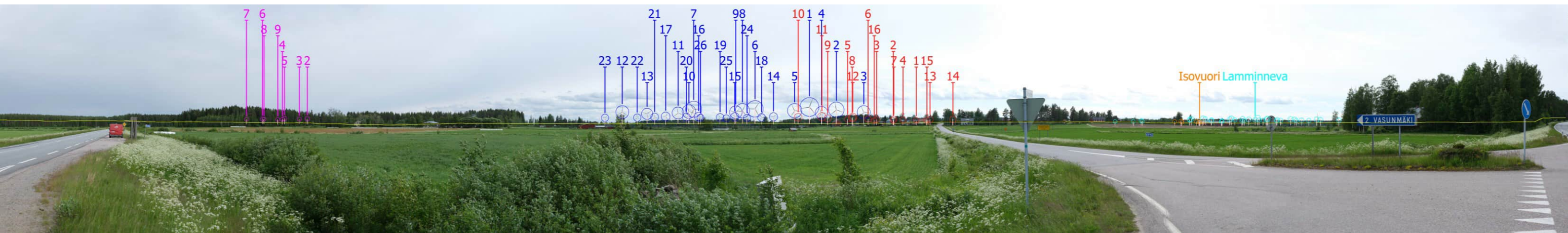
Kuva 38. Valokuvasovite kuvauspisteestä 6 vaihtoehdossa 1 (VE1) on otettu Salmentien ja Lapuantien risteyksestä. Etäisyys lähimpiin voimaloihin on noin 5,9 km. Palopättärämäen voimaloiden roottoriympyrät on korostettu punaisella. Napalankalliot-Hietaharjun voimaloiden roottoriympyrät on korostettu sinisellä. Rakennettavan Sarvinevan voimaloiden roottoriympyrät on korostettu lilan värillä.
