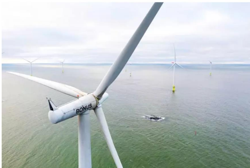
Kasvanut tuulivoimatuotanto on vähentänyt Suomen sähkön käytön ilmastopäästöjä. Kuvassa meritulipuisto Reposaareissa Porin edustalla vuonna 2020. KUVA: SAMI KERO / HS
